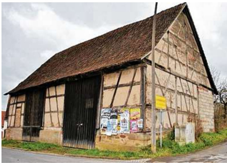
Aufgabe im neuen Jahr: Die Sanierung der Zentscheune gehört zu den Maßnahmen bei der Dorferneuerung.
