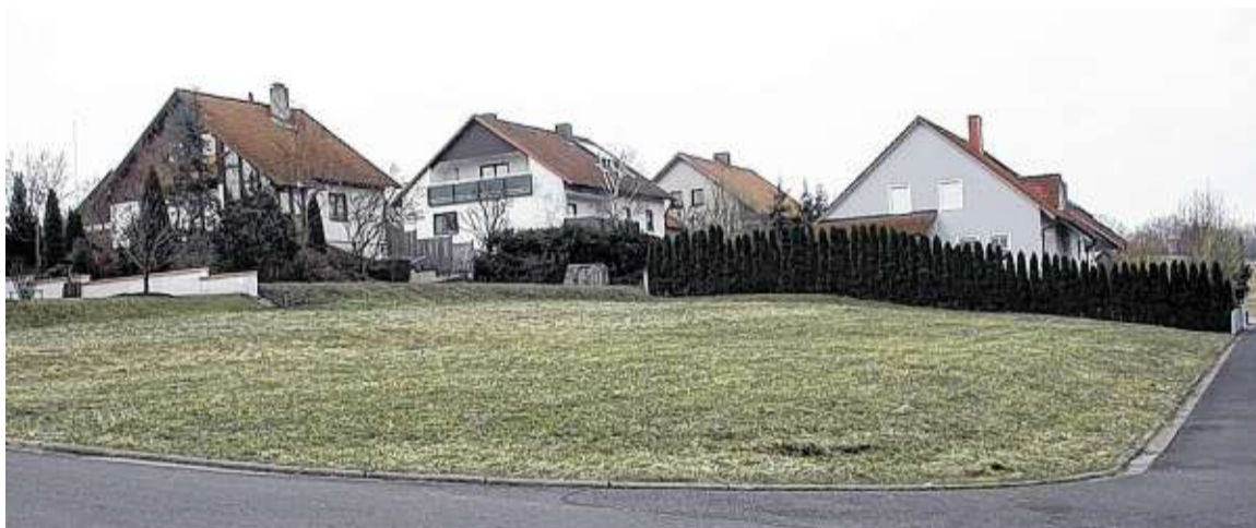
Es klaffen Lücken: Wie hier im Höchheimer Neubaugebiet „Leite“ gibt es in allen vier Höchheimer Ortsteilen noch eklatante Baulücken. Mit einer Sonderverkaufsaktion von Bauplätzen will die Gemeinde jetzt Interessierte zum Kaufen und Bauen anreizen.
